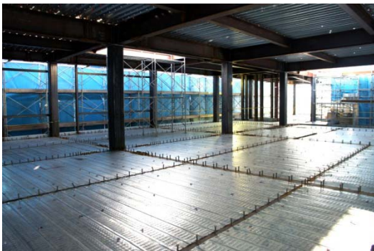
デッキが引かれた3階部分の床
