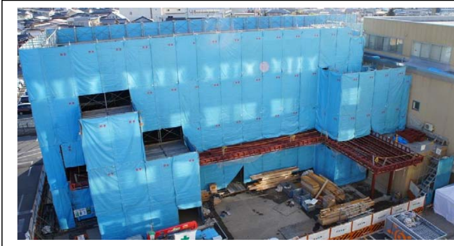
防音のブルーシートに覆われた新棟
