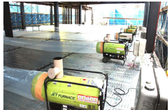
コンクリート打設を行った階の下からジェットヒーターで採暖中
