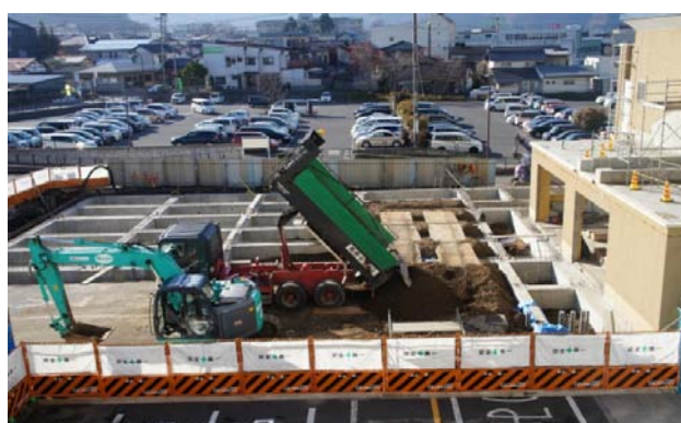
ダンプカーによる基礎埋め戻しのための土搬入
