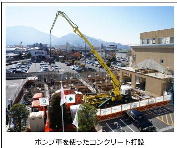
ポンプ車を使ったコンクリート打設
