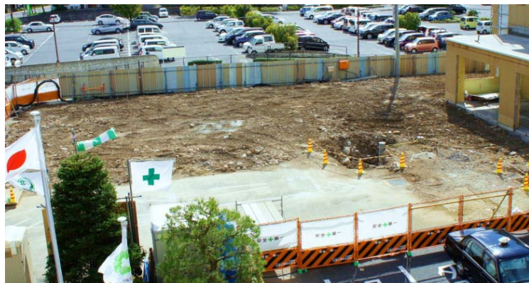
更地となった新棟建設予定地
